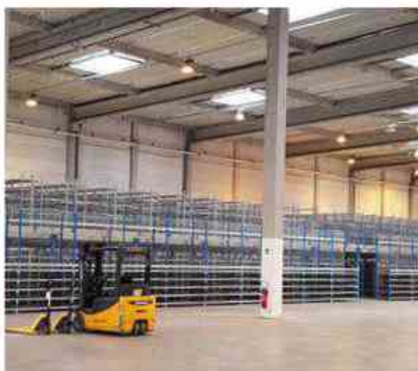
Installation d'envergure mixant rayonnages et plates-formes.
